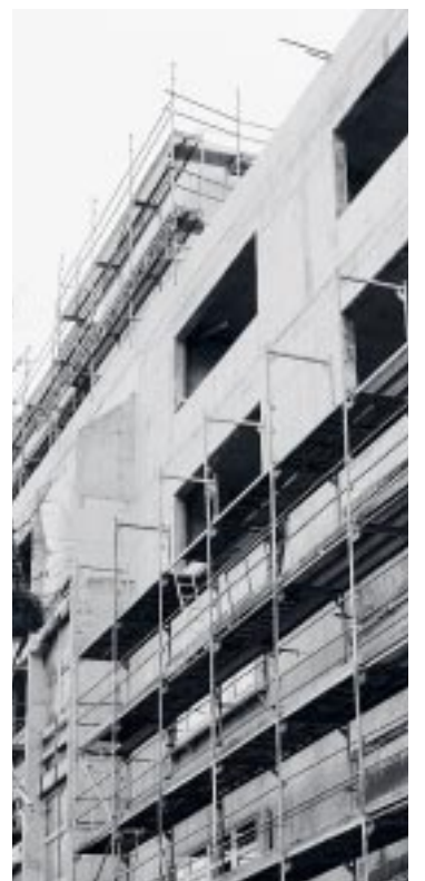
Der zweite Bauabschnitt des neuen Physikgebäudes (Foto: Bernd Beuermann)
