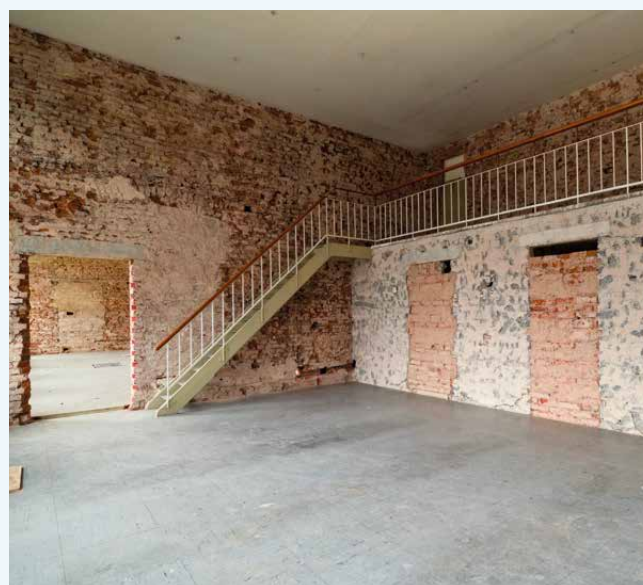
Abbruch- und Entkernungsarbeiten
